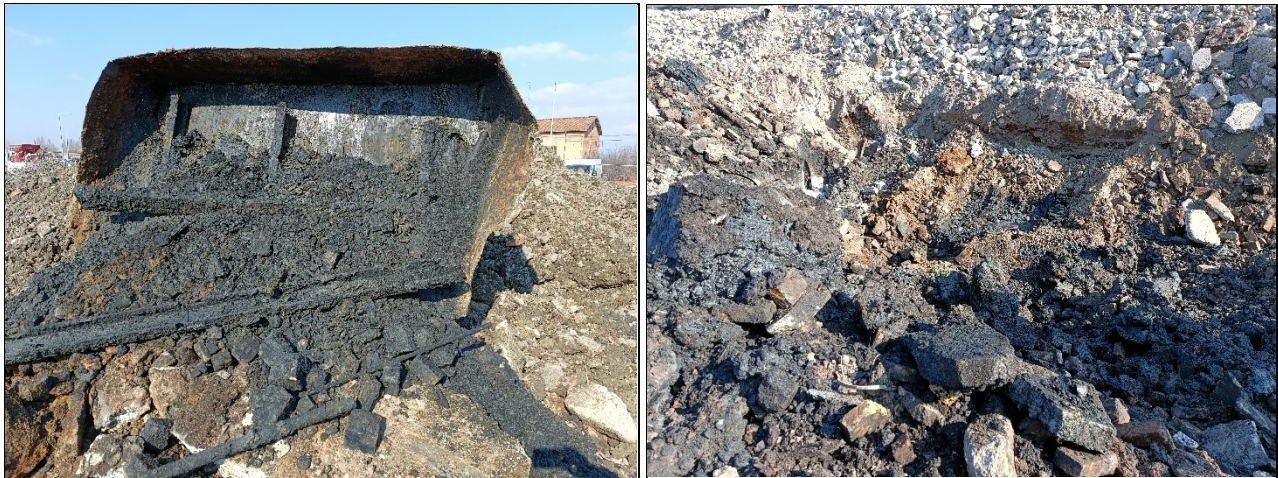
Figura 5: cisterna in acciaio rinvenuta sotto una soletta in calcestruzzo e dettaglio del terreno nel suo intorno
